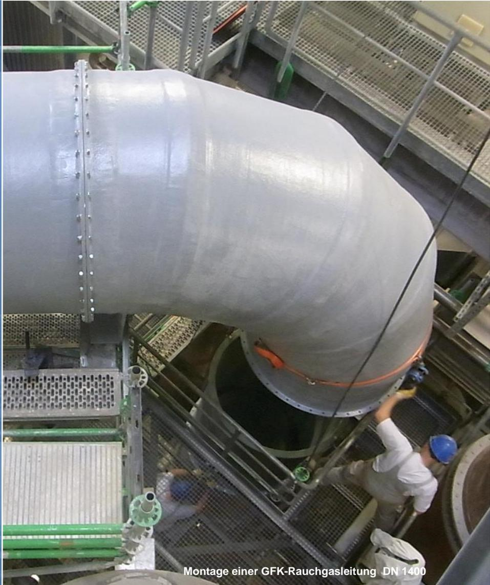
Montage einer GFK-Rauchgasleitung DN 1400
