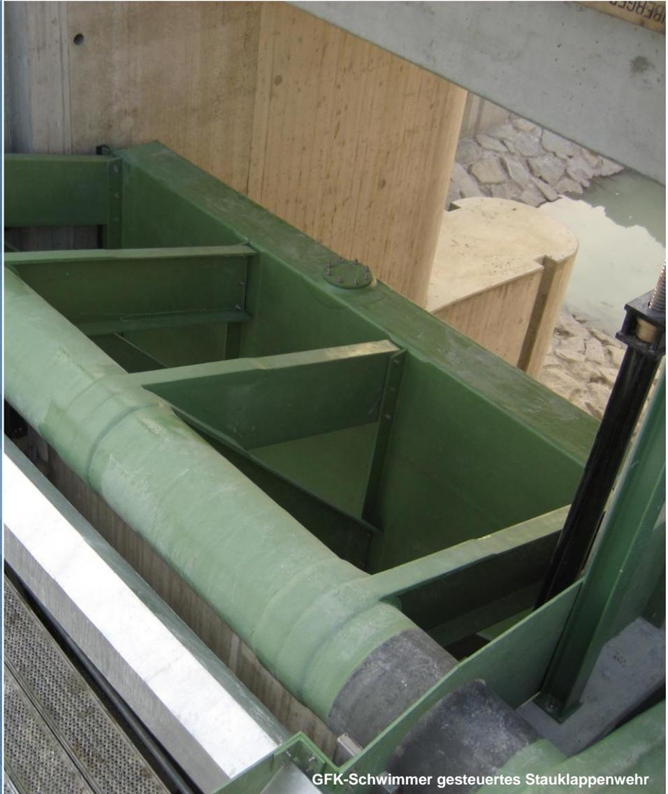
GFK-Schwimmer gesteuertes Stauklappenwehr
